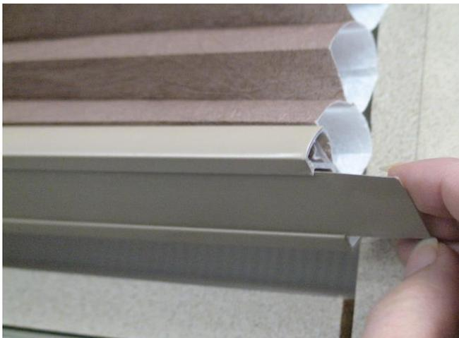
**3. Retirer les poids du rail de bas un à un en commençant par le poids du milieu. Il est préférable d’utiliser un tournevis plat (couvert avec une serviette pour éviter de gratter la peinture). Verifier l’opération et retirer d’autres poids au besoin. Rassurer vous que le store est bien balancé quand les poids ont été retirés**
