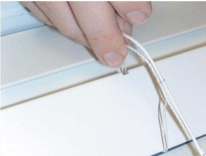
7. Levez et abaissez le store avec les lamelles en position ouverte afin de s'assurer qu'il fonctionne correctement.
