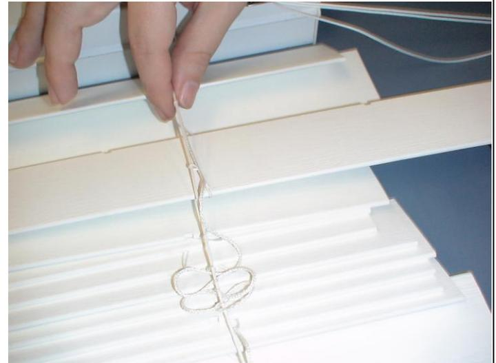
6. Glissez la lamelle de rechange dans les échelles en veillant à ce qu'elle repose sur le dessus du barreau d'échelle. Continuer pendant toutes les lamelles de remplacement. Rassurez-vous que les cordons d'échelles traversent les encoches à l'arrière des lamelles.
