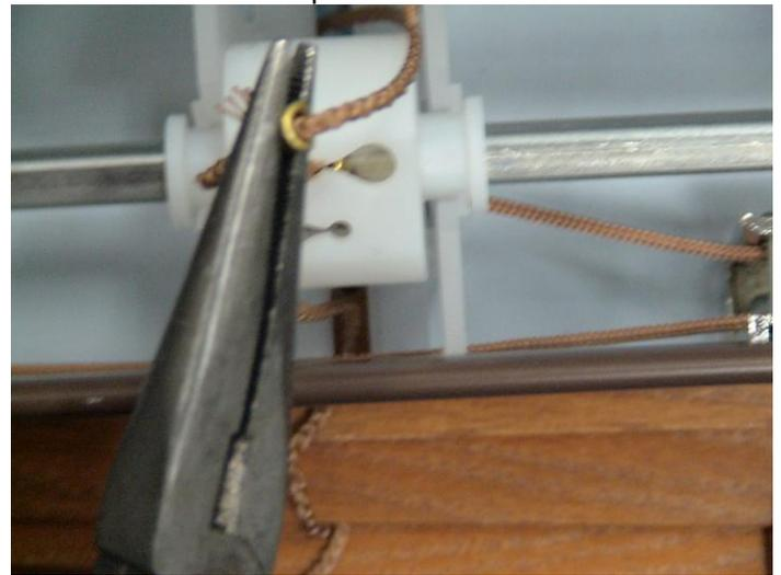
7. Si les échelles sont détachées du tambour de ruban, utilisez des pinces nez aiguille pour récupérer le cordon de l'échelle. Retirez l'échelle de cordon dans les fentes de tambour de ruban.
