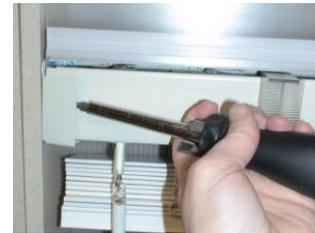
3. Enlevez la tige d'inclinaison. Si le store a une tige avec un clip de connecteur, utilisez des pinces nez aiguille pour saisir le clip de connecteur au-dessous de la tige d'inclinaison. Tordez le fil pour le dégager des rainures dans le système de d'inclinaison.
