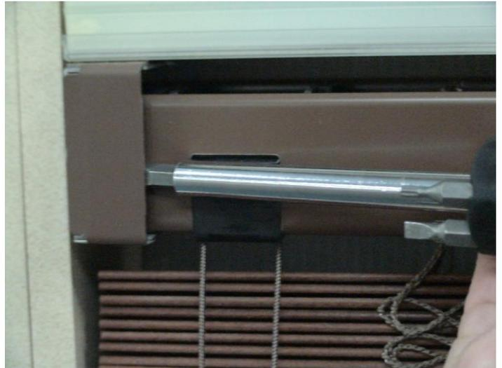
3. Assurez-vous que la tringle d'inclinaison est complètement dans le mécanisme d'inclinaison. La tringle d'inclinaison sera insérée afin que vous puissiez le voir sur les deux côtés du mécanisme d'inclinaison.
